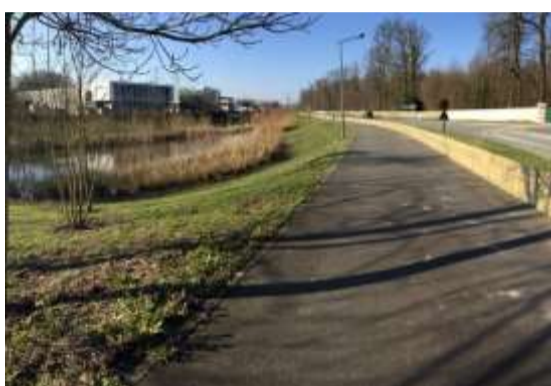
Le Crapauduc le long de la RD218 – Bassin du Gué Langlois à Gauche et Parc de Rentilly à droite (Source : CAMG)
