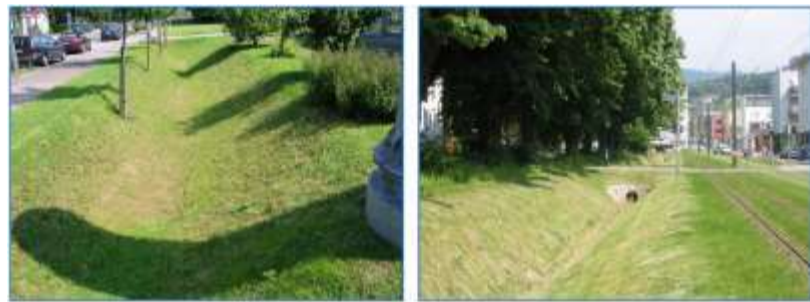
Noue (à gauche) et fossés d'infiltration (à droite) équipant la quartier Vauban à Fribourg
