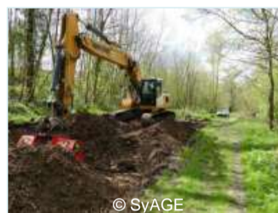
© SyAGE Terrassement et criblage
