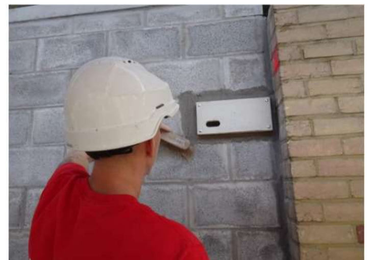
15 nichoirs à martinets intégrés dans les parpaings
