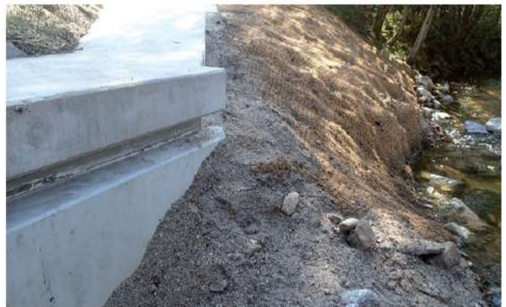
Planche-photos 1 : illustrations de l'ouvrage et son réaménagement pour la petite faune (photos prises en phase chantier). © GREGE Haut : Vue générale de l'ouvrage du Deiro - Bas : Aperçu de la banquette faune et de l'encoche « micromammifères » créées et de leur raccordement à la berge en aval.
