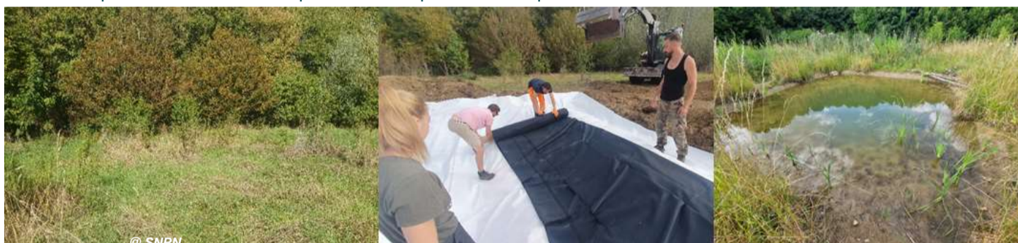
Milieu avant la mise en place de la mare. Phase de chantier, installation de la membrane EPDM. Mare finalisée, après la mise en œuvre d'actions correctrices. Source : SNPN
