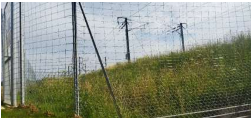
Espace défavorable à la faune de l'autre côté de la clôture : mailles à diamètre restreint en bas de clôture (source : Biotope)
