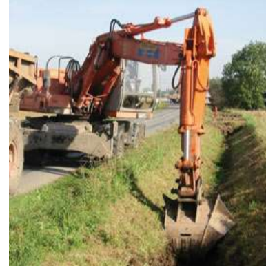
Curage de fossé avec godet trapézoïdal (source sotraveer)
