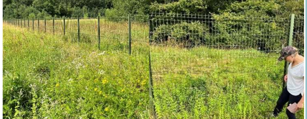
Espace favorable à la faune de l'autre côté de la clôture : mailles à diamètre large en bas de clôture (source : Biotope)
