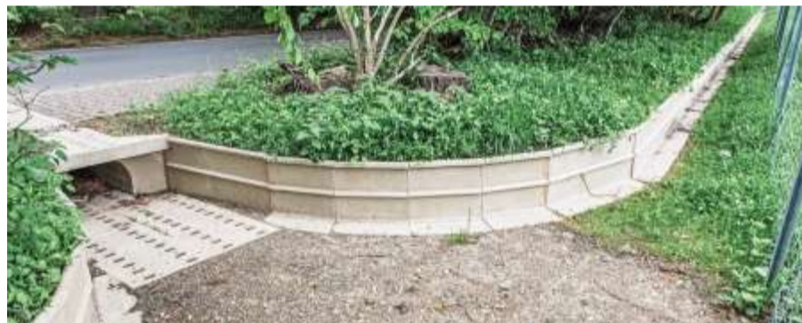
Exemple d'un passage à amphibiens et micromammifères sous voirie – ACO France
