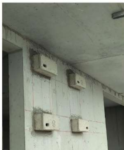
70 nichoirs à martinets intégrés dans les réservations
