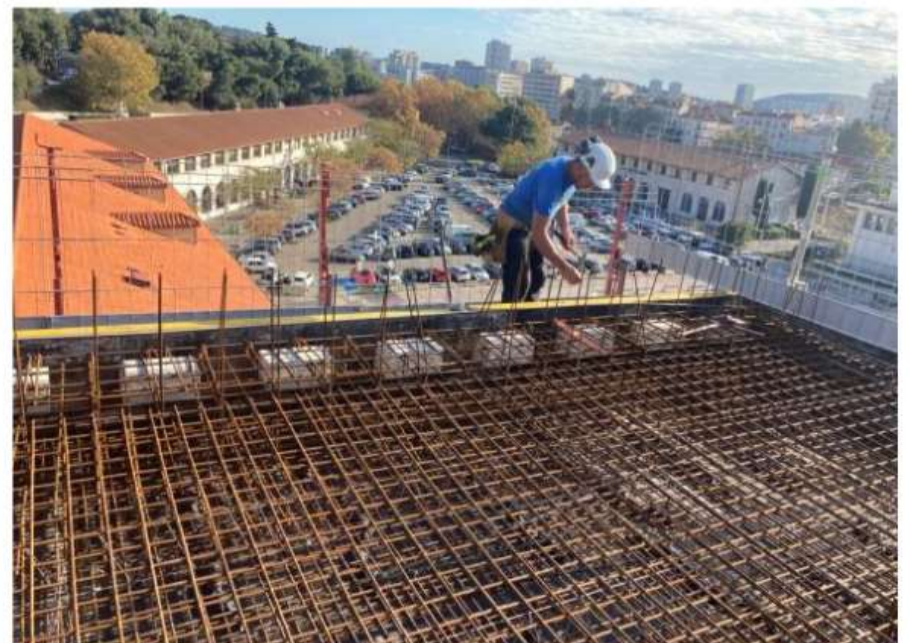
25 Nichoirs à martinets intégrés dans le plancher
