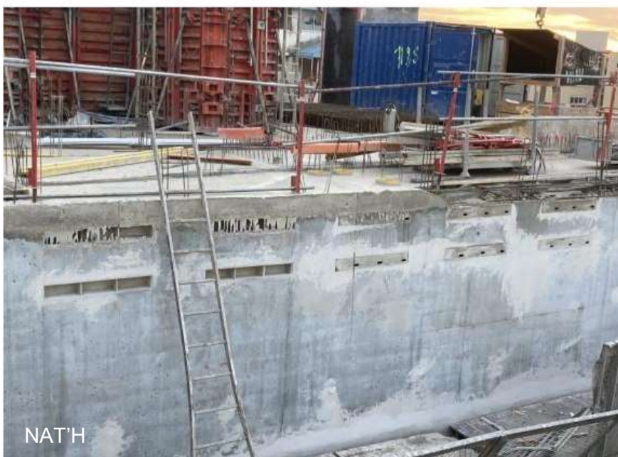
18 Nichoirs à martinets (triple chambre) intégrés dans les banches
