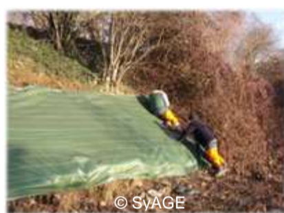
© SyAGE Pose de bâche sur talus à forte pente
