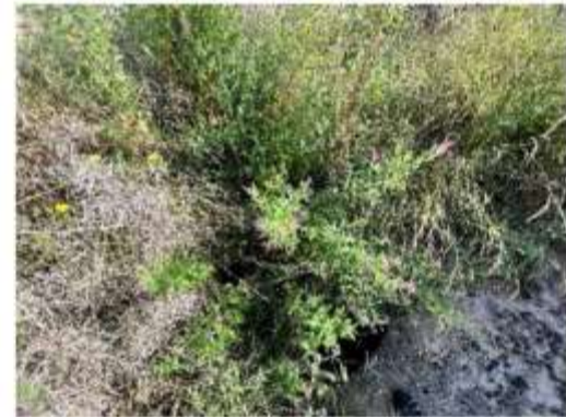
3. Exutoire d'une buse faible diamètre passant sous la D 471
