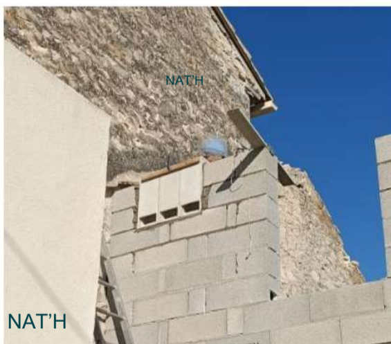
3 gîtes à chauves-souris intégrés en batterie
