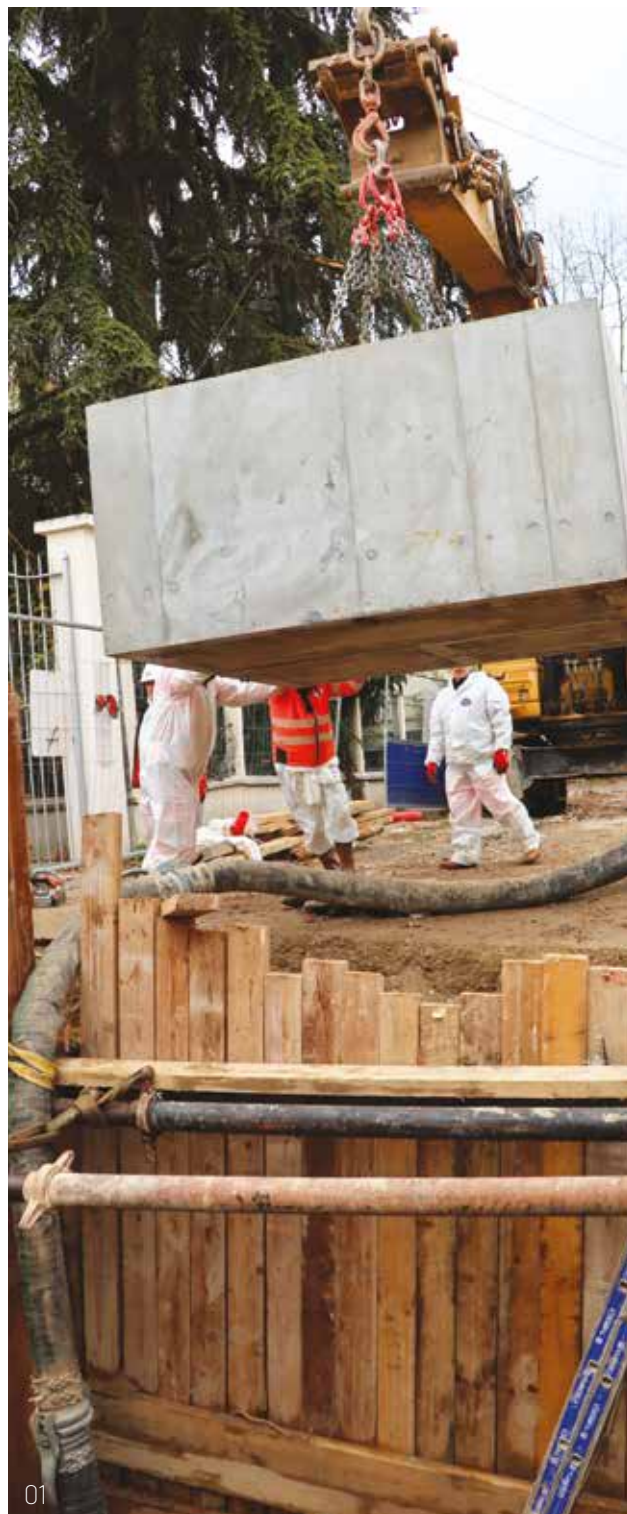
01. Installation d'un regard en béton de 18 tonnes, rue Belleplace
